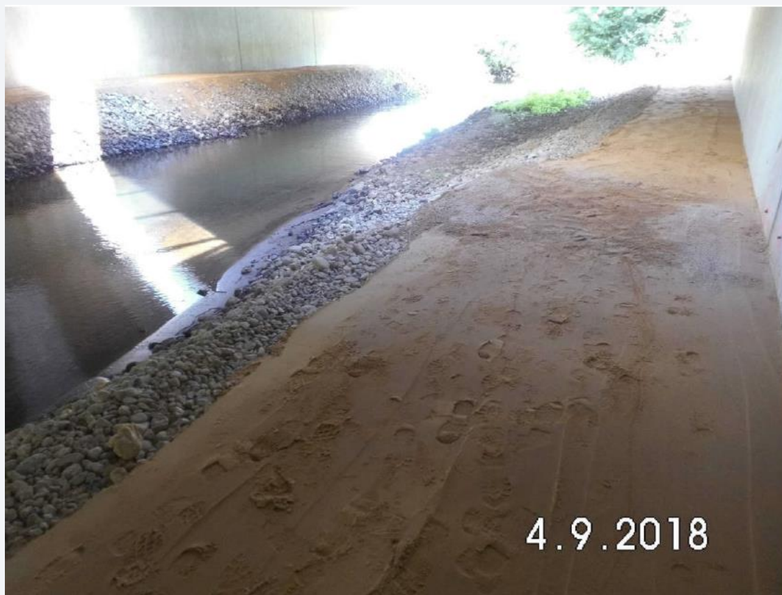
Gewässer BW 308, Osterau. Nachträgliches Aufbringen von Sand.
